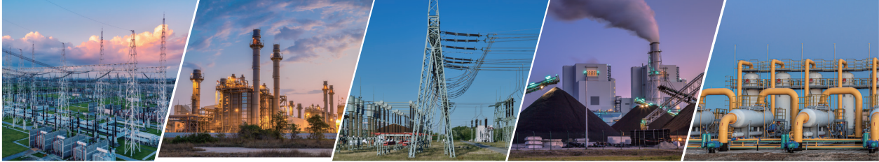
Zusätzliches Umspannwerk (Energiepark)
